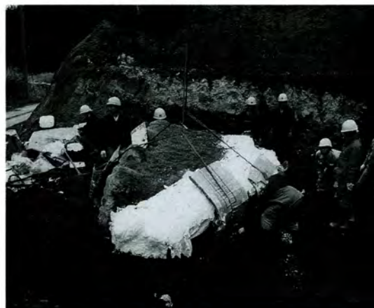
5-2. 最大のブロックを引き上げる (1994.11.25)
