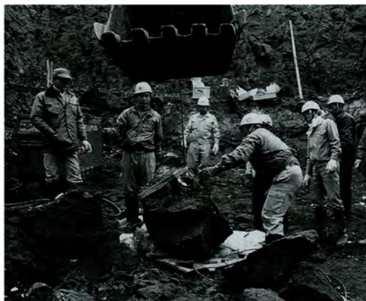
5-3. 割れたブロックを引き上げる (1994.11.25)
