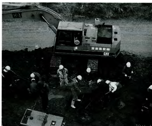
1-2. 東側の掘り込みが進む (1994.11.19)
