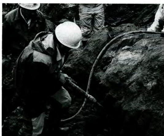
1-3. 削岩機によって掘り下げる (1994.11.19)
