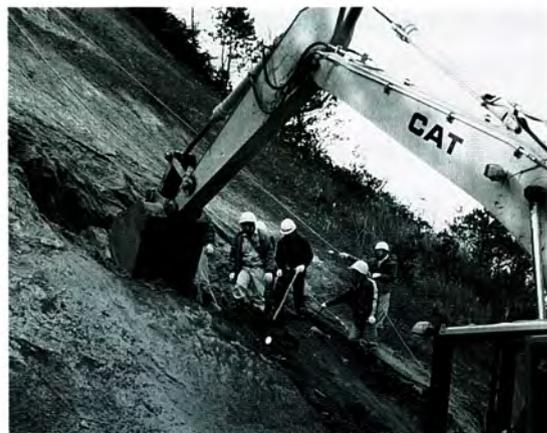
4. 砂岩層をバックホーで掘り込む。(1993.11.9)
