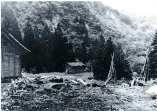
昭和47年5月24日 三軒の住居は解体され無人境となつていた。
